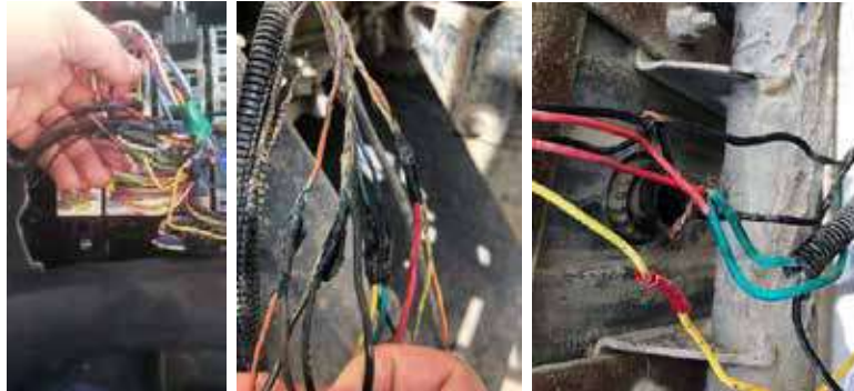
Exemplos de ligação inadequada de cabos
